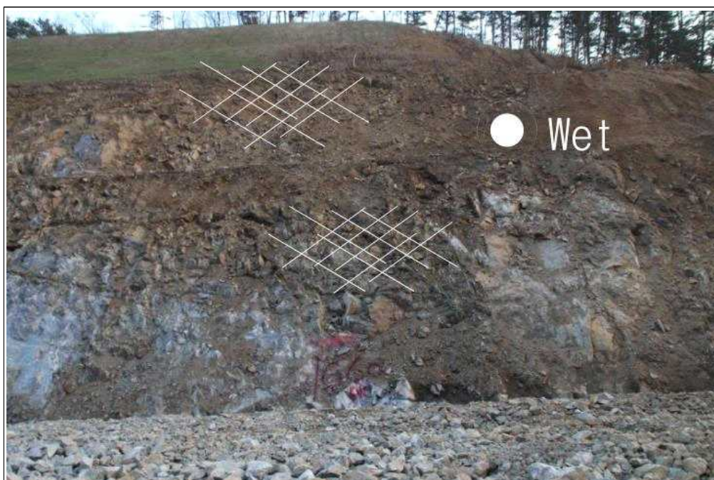
【그림 23】 C 영역 상세사진(세편화된 암석 및 지하수유출)
