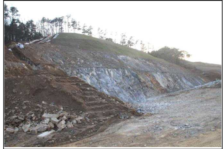
【그림 4】 깎기비탈면 종점부 측면 사진
