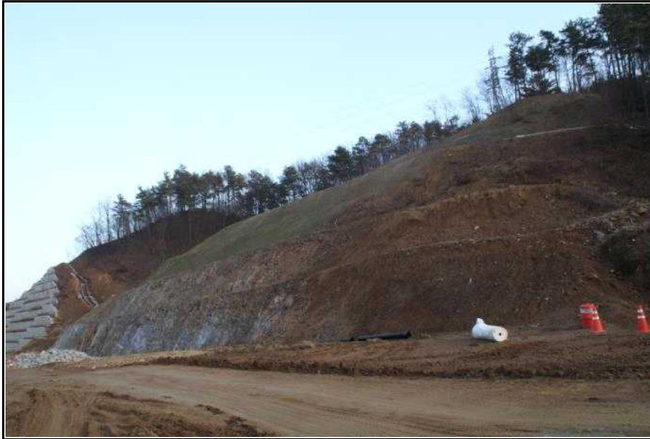
【그림 3】 깎기비탈면 시점부 측면 사진
